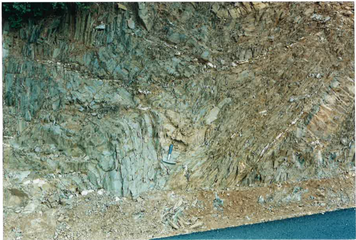
Foto 14. Pliegue de Fase 1 en el tránsito Alternancias del Caño-Pizarras Guindo, en la Ctera. Nal 410 Calzada de Calatrava-Almuradiel.
