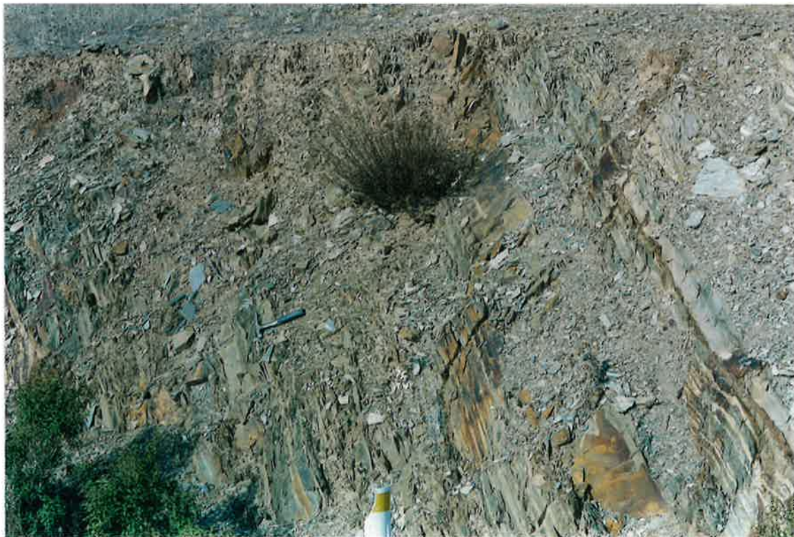
Foto 10. Tránsito Pizarras de Río-Alternancias del Caño en el km. 3,4 de la Ctera Viso del Marqués-S. Lorenzo de Calatrava.
